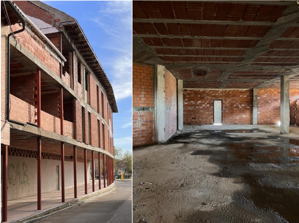
Estado actual de la edificación
